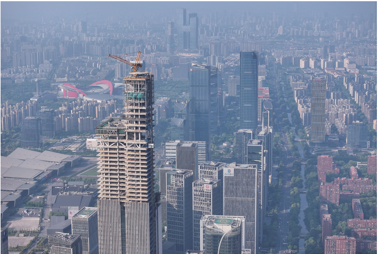
南京超高層建築項目施工中。(圖片來源：新華社)
