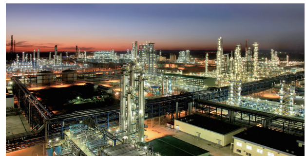
遼河石化廠區夜景。
