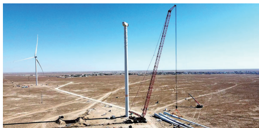
寰泰能源在哈薩克斯坦投建的Sarkylmas Kuat 50MW風電項目完成風機吊裝，這是公司首個實現自主吊裝作業的風電項目。
